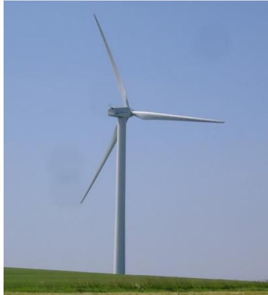
Figura 17. Generador de eje horizontal. Gamesa
