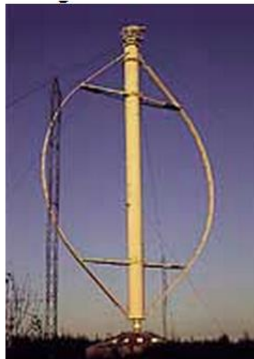
Figura 18. Aerogenerador de eje vertical. WindPower.
