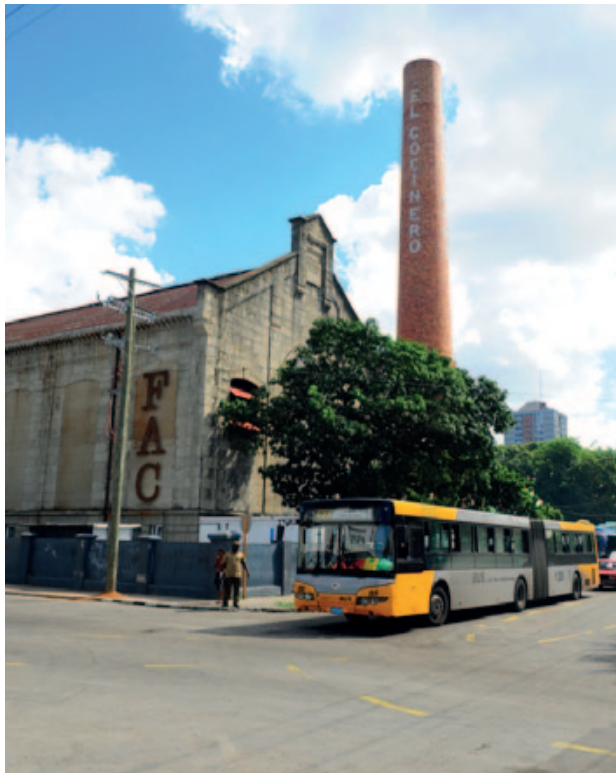
Figura 2: Aspecto exterior del inmueble en la actualidad.
