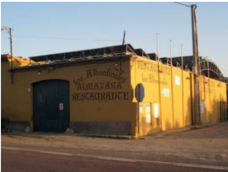
Figura 6: Vista exterior del inmueble en la actualidad.
