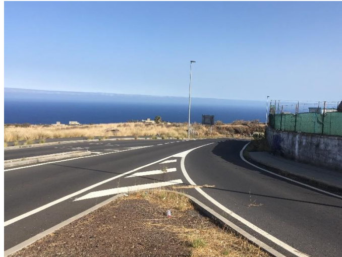
Figura 7. Inicio del tramo de estudio de la carretera de Santa María del Mar. Fuente: Elaboración Propia.
