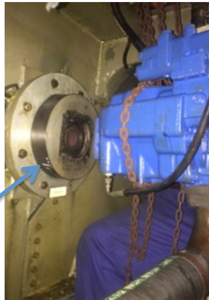
Ilustración 70: Damping Ring Fuente: Trabajo de campo
