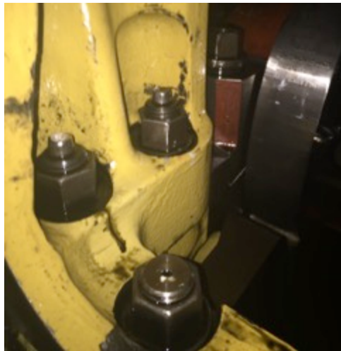
Ilustración 84: Rotabolt SOME lado B Fuente: Trabajo de campo
