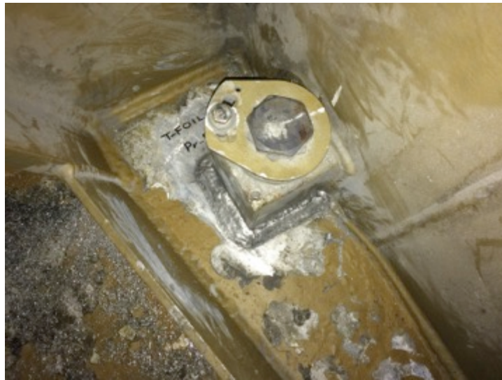
Ilustración 82: Pernos T-Foil Fuente: Trabajo de campo
