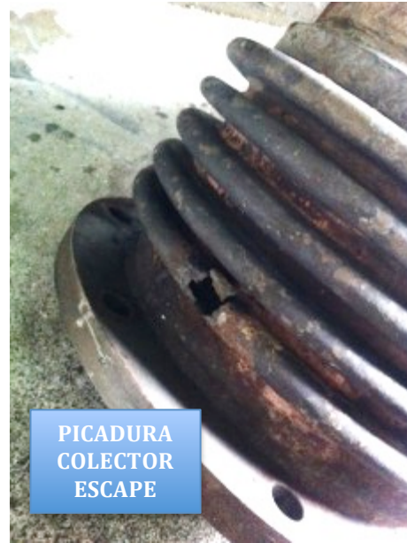
Ilustración 67: Tramo colector escape Fuente: Trabajo de campo
