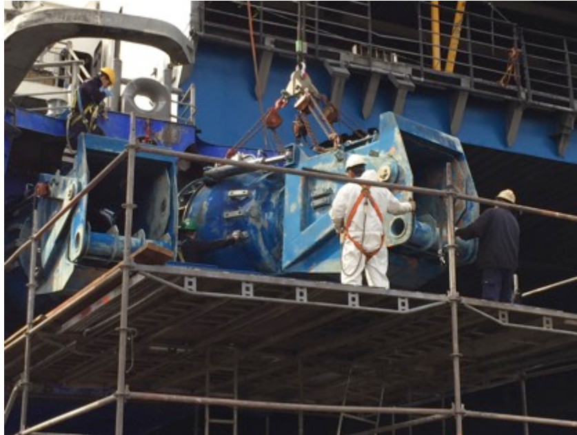
Ilustración 100: Extracción waterjet babor Fuente: Trabajo de campo
