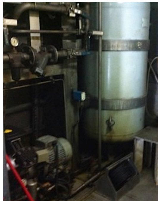
Ilustración 14: Sistema neumático Fuente: Trabajo de campo
