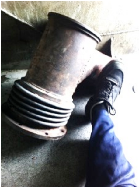
Ilustración 66: Tramo colector escape Fuente: Trabajo de campo
