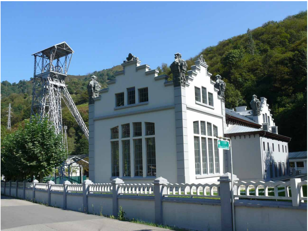
Figura 2: Pozo San Luis, La Nueva (Asturias), lugar de interés patrimonial del Ecomuseo de Samuño.
