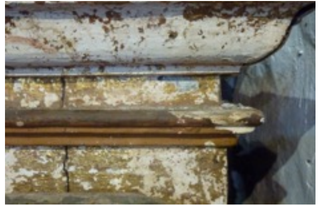
Fig. 46. Detalle del dorado del banco de la epístola de donde se pueden apreciar los estratos de aparejo bol y pan de oro que conforman el dorado.
