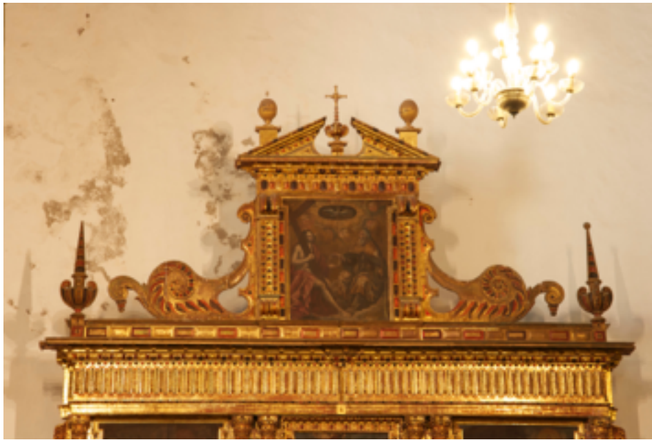
Fig. 14. Fotografía del ático y coronación en la que podemos observar donde están situadas las veladuras que hemos descrito.
