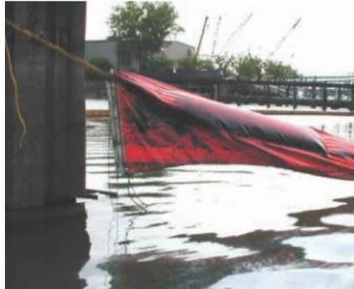
Imágen VI.50 * La barrera pierde hidrocarburos por debajo debido a un amarre de longitud insuficiente provocando que la barrera quede suspendida durante la marea baja.
