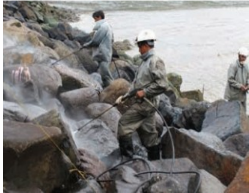
Imágen VI.109 * Limpieza de escollera con agua a alta presión.
