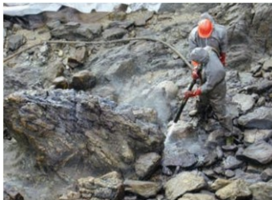
Imágen VI.97 * Limpieza de las rocas con agua a baja presión.
