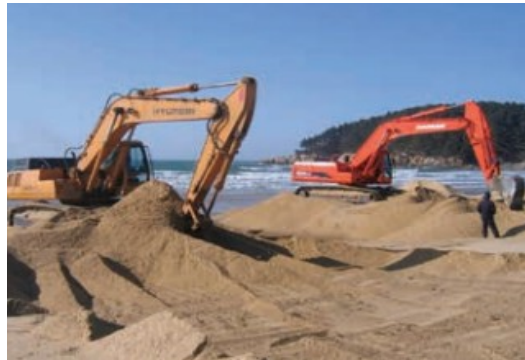
Imágen VI.103 * La arena contaminada se mueve hacia las zonas intermareales para que sean lavadas por las olas.
