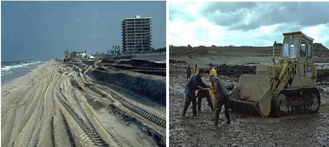
Imágen VI.89 * Limpieza con sistemas mecánicos.
