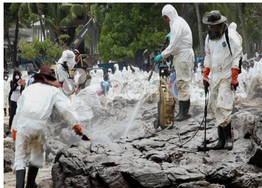
Imágen VI.24 * Lavado con chorros de agua a alta presión.
