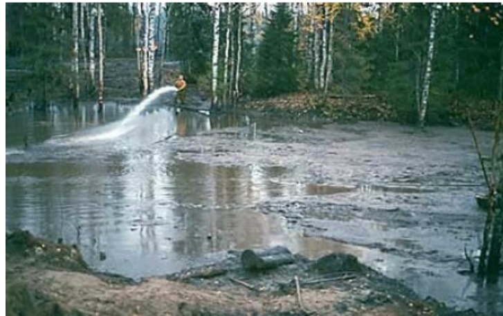
Imágen VI.93 * Limpieza con agua a baja presión.
