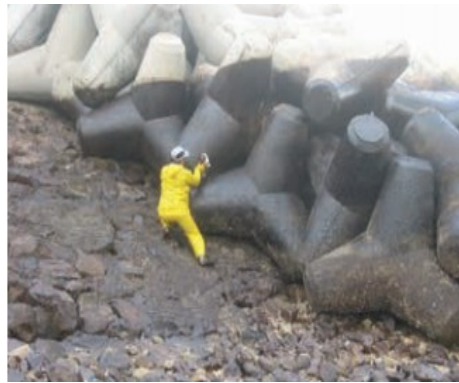
Imágen VI.107 * Limpieza de tetrápodos contaminados por hidrocarburos.
