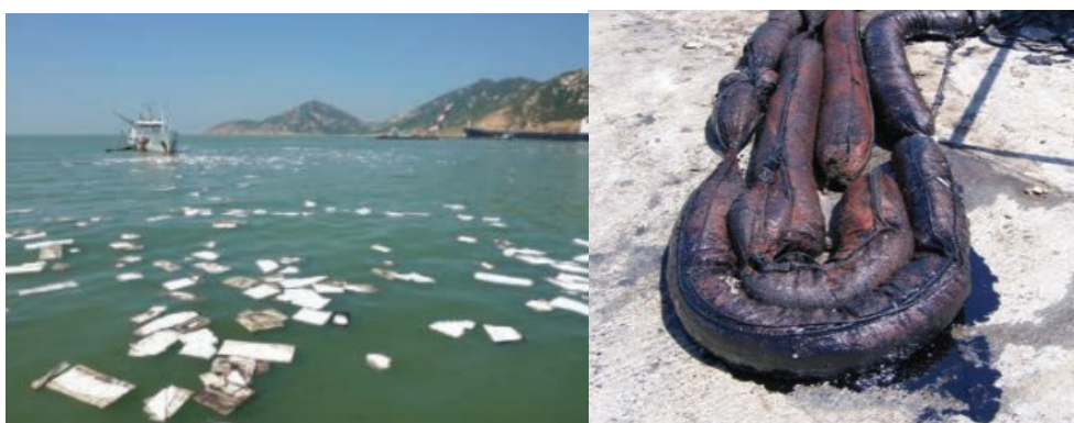
Imágen VI.73 * A la izquierda se encuentra la aplicación de almohadas adsorbentes y a la derecha se muestra la lixiviación de hidrocarburos de una barrera adsorbente.
