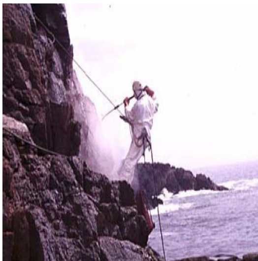
Imágen VI.95 * Limpieza con vapor de agua.
