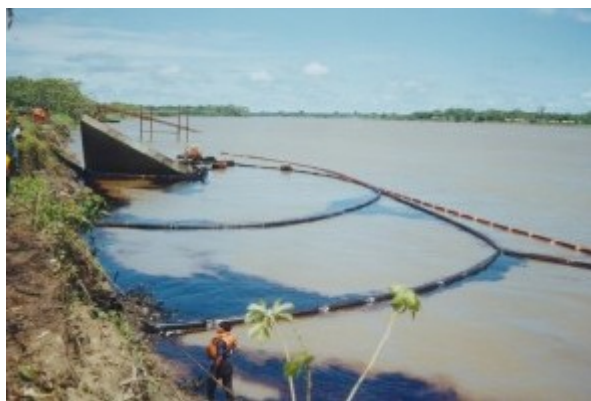
Imágen VI.60 * Configuración múltiple de barreras en un derrame de petróleo en San José de Saramuro (Perú), año 2000.
