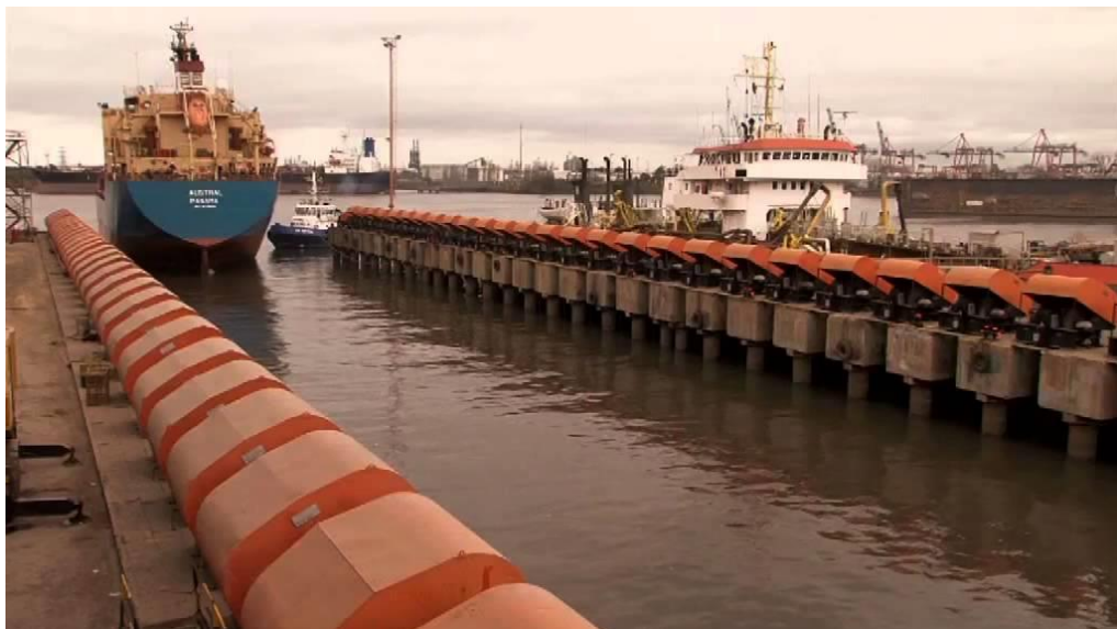
Syncrolift de astillero Tandanor, Argentina
