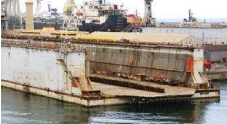
Dique flotante en Nápoles, Italia
