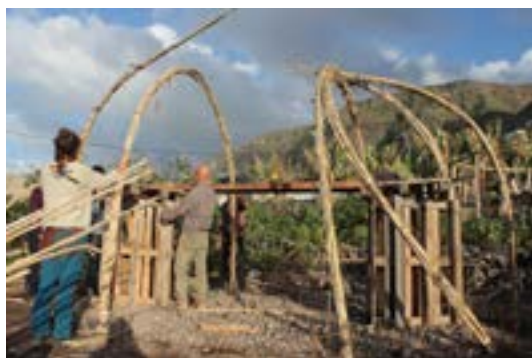
Primeros arcos, se han colocado los laterales que con tres medios arcos forman la curva atándolos entre si en los puntos de apoyo.
