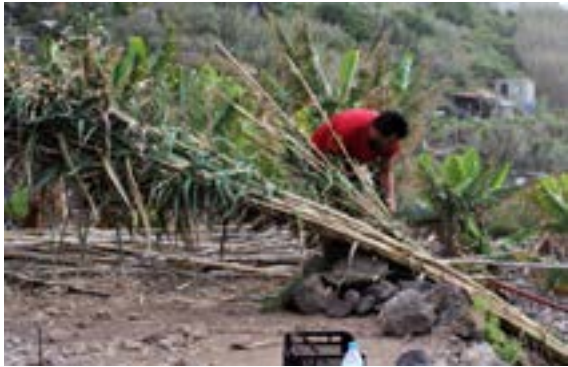
La caña como elemento estructural, se ha recogido en los barrancos, la caña es infuga y resistente, según su estado puede ser flexible y moldeable.
