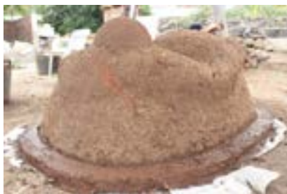
Un margen de la misma masa separa del suelo la pieza que se extraerá después
