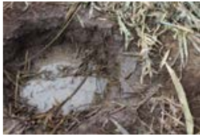
Extracción de la tierra, mezclada con agua y hojas de caña
