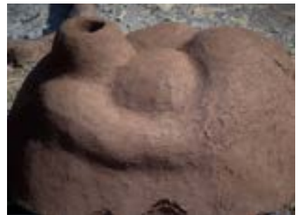
La pieza se tiene que reconstruir las partes agrietadas, (puerta y bordes de apoyo),ubicarla, y encender fuego en su interior.
