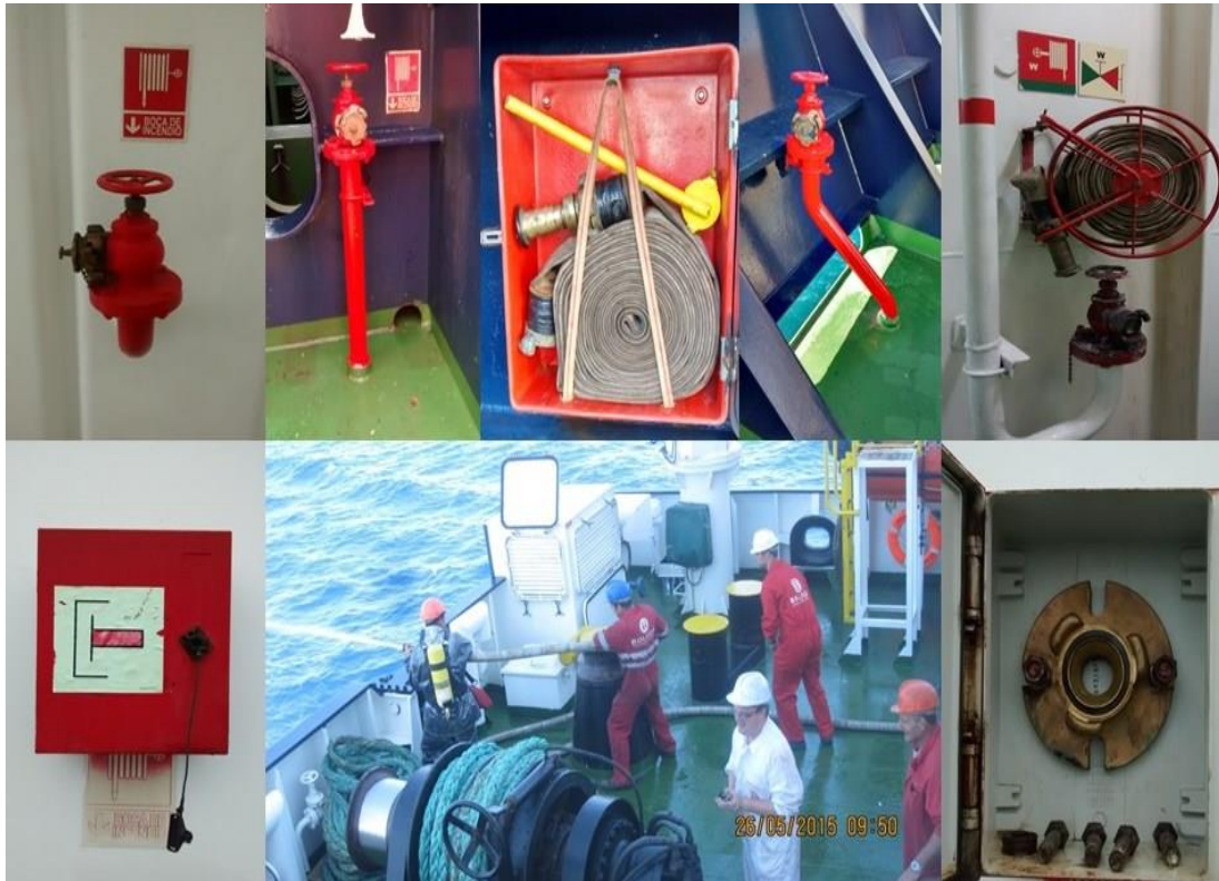
Sistema contraincendios por agua . Fuente : Elaboración propia
