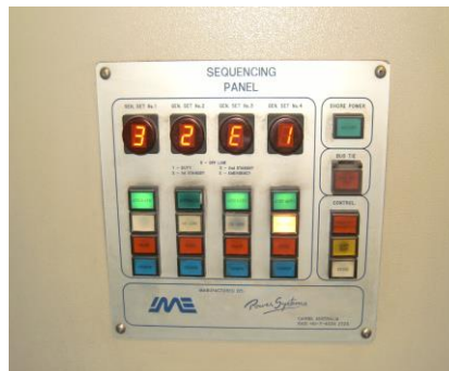
Fig. 22. Control de secuencia de los Motores Auxiliares
