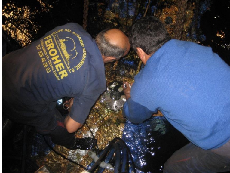
Fig. 62. Operario extrayendo el casquillo de unión del Jetavator
