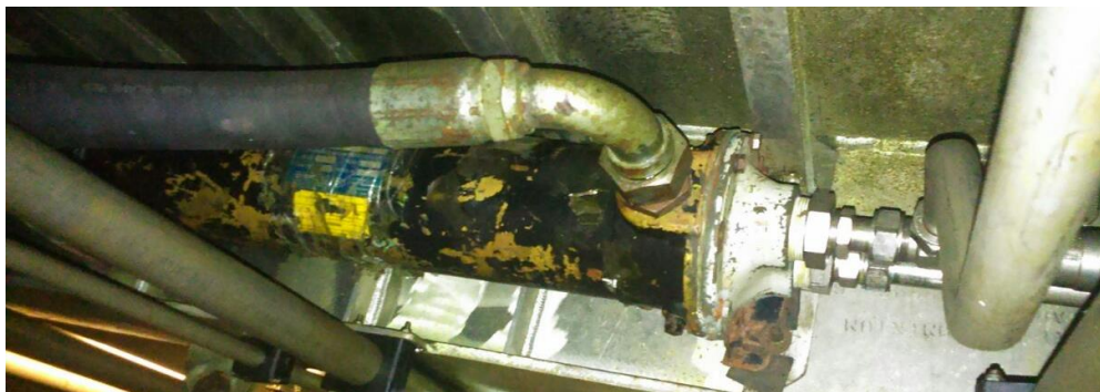
Fig. 55. Enfriador aceite hidráulico/agua
