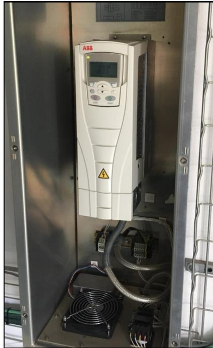
Figura 12. Variador de frecuencia ABB modelo ACS55. [Fuente: elaboración propia]
