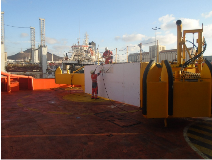
13 Preparación para el izado del brazo Kamper. Fuente: Trabajo de campo
