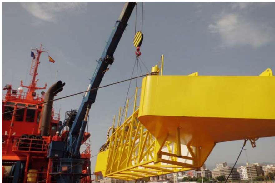
18 Ayuda mediante cabos para el traslado del brazo Kamper. Fuente: Trabajo de campo
