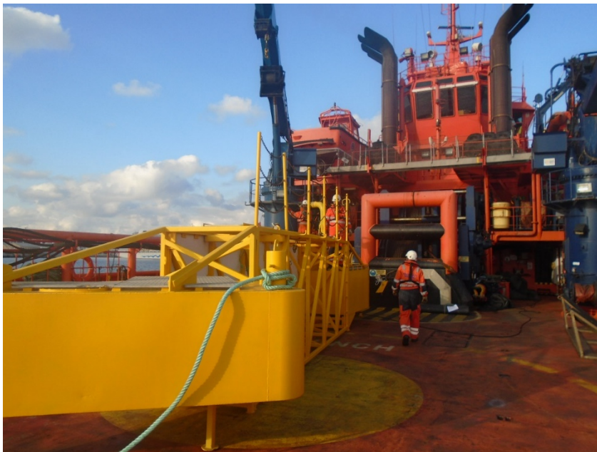
14 Preparación para el izado del brazo Kamper. Fuente: Trabajo de campo
