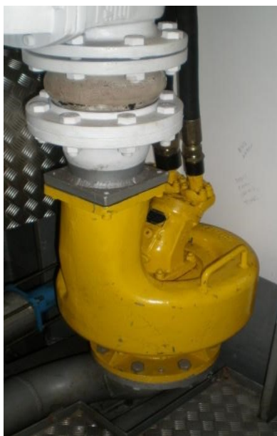
66 Bomba centrífuga Marflex. Fuente: Trabajo de campo
