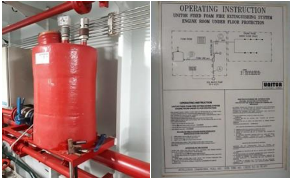
Ilustración 13: Sistema de espuma contraincendios. Fuente: elaboración propia.
