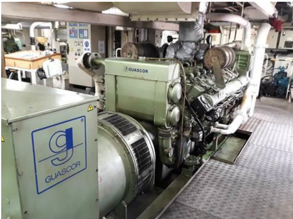
Ilustración 3. Motor principal. Fuente: Trabajo de campo.
