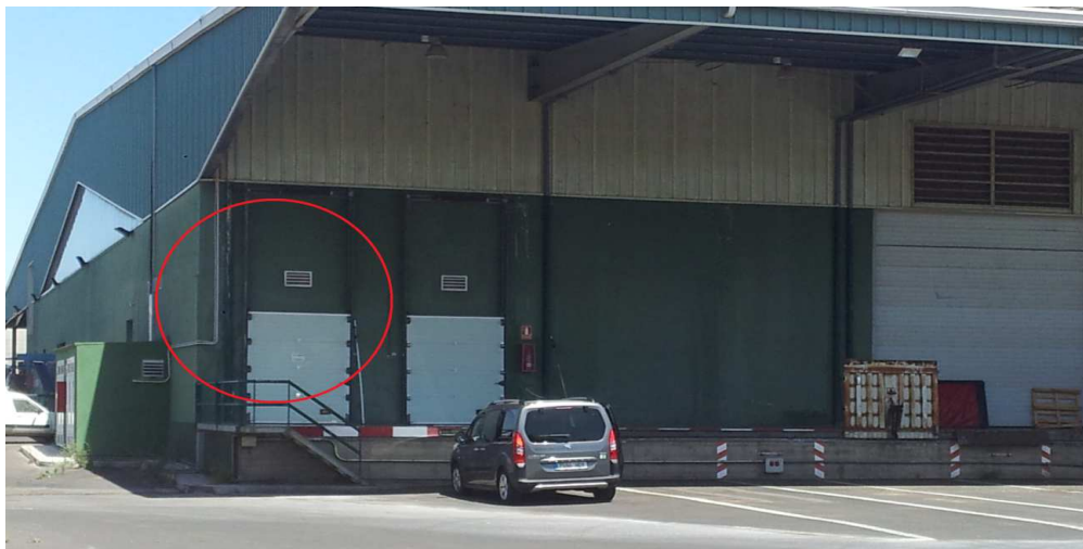
Figura 3: Situación de las cámaras
