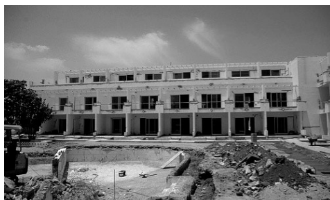
Durante la renovación
