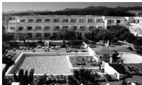
Antes de la renovación
