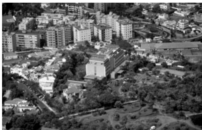
Imagen 3. Vista de la fachada sur- sureste del hotel, prácticamente sin huecos
