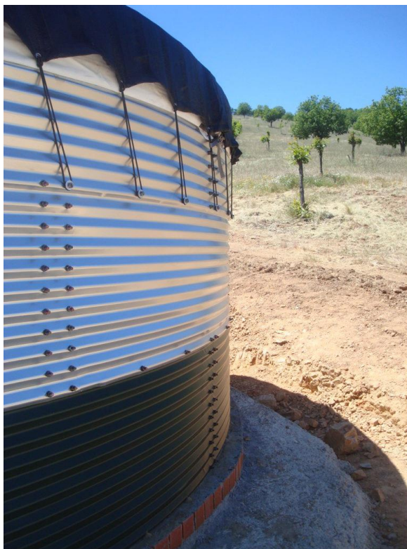
Ilustración 2. Depósito con la chapa inferior con el recubrimiento plastisol verde anticorrosión. Fuente: Fabricante, (Déndromon – Genap).
