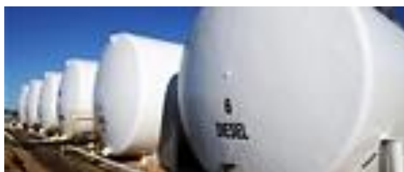
Figura 3.6. Depósitos homologados para gasoil 2000 Litros
