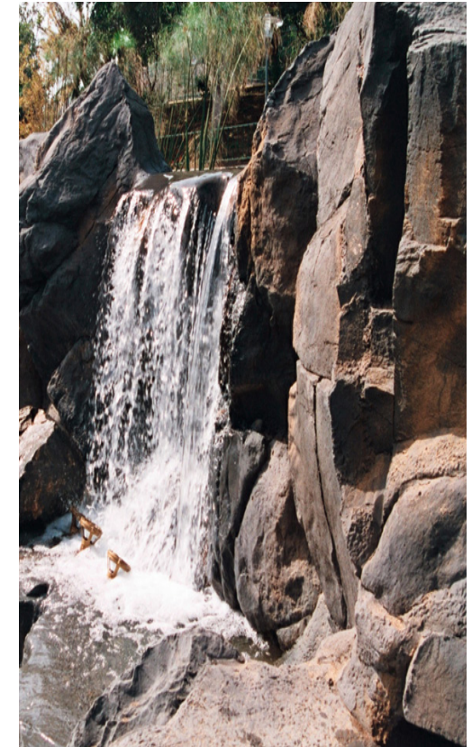
Realizada con mortero tixotrópico
