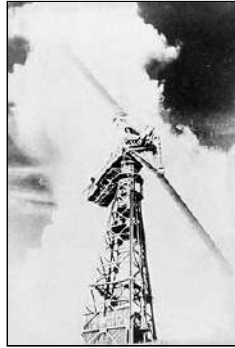
Figura 8: Aerogenerador Smith putman
