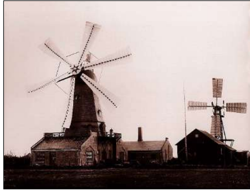
Figura 6: Dos de los aerogeneradores de prueba de Court en 1897 en el instituto de Askov Folk, Askov (Dinamarca),
