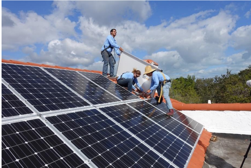
Imagen 4 - Módulos FV en instalación de panel doble
