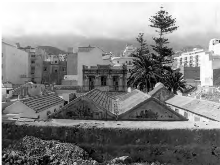
Foto 1. Ciudadela de Mequinez o Adelaida. En primer plano, el muro de protección frente a las crecidas del mar. Cuatro naves –la nave central es doble–, separadas por dos pasillos.
