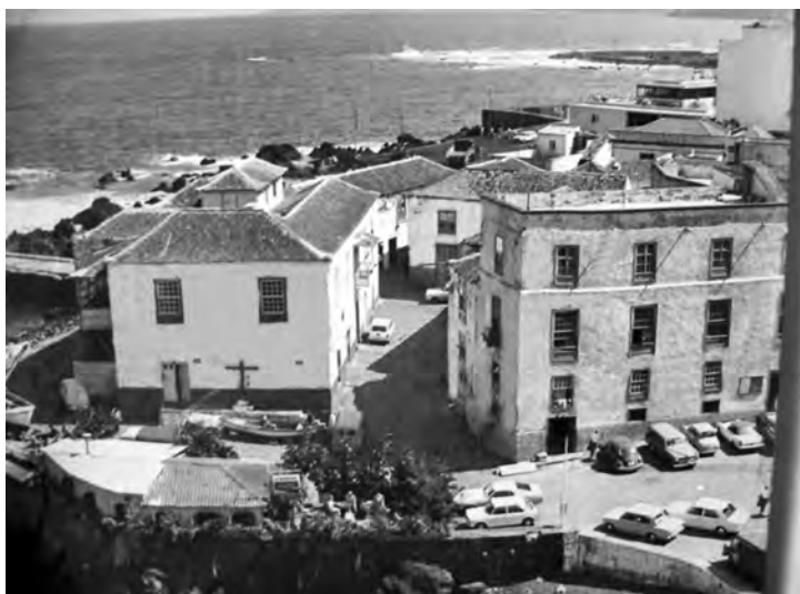
Foto 6. Ciudadela casa Cullen, edificio de cuatro plantas, situado a la derecha de la imagen.
