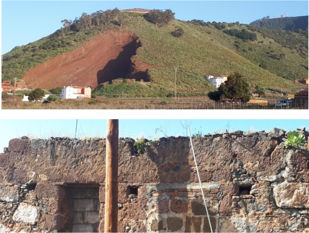
Figura 2. Ejemplos de la gea presente en afloramientos naturales (arriba) y en el patrimonio cultural tangible inmueble (abajo) en Tegueste
