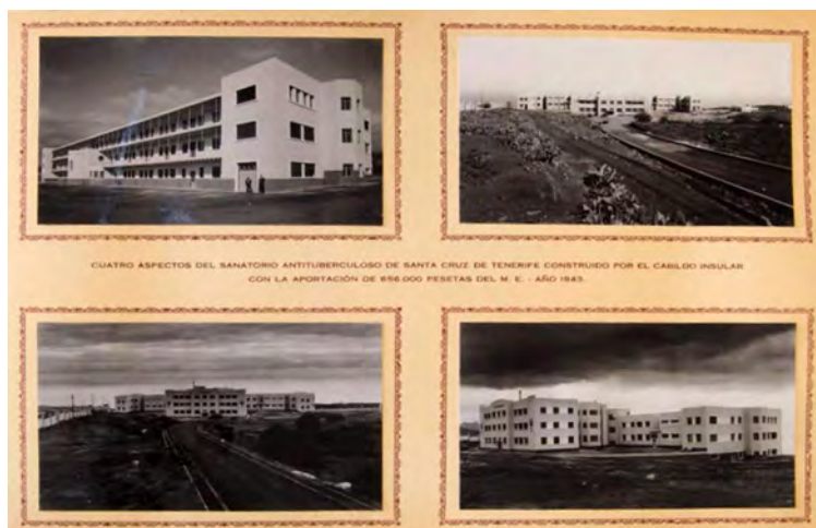
Fig. 15. Construcción del Hospital Antituberculoso de Santa Cruz (hoy Hospital Universitario de Canarias). Año 1943.
