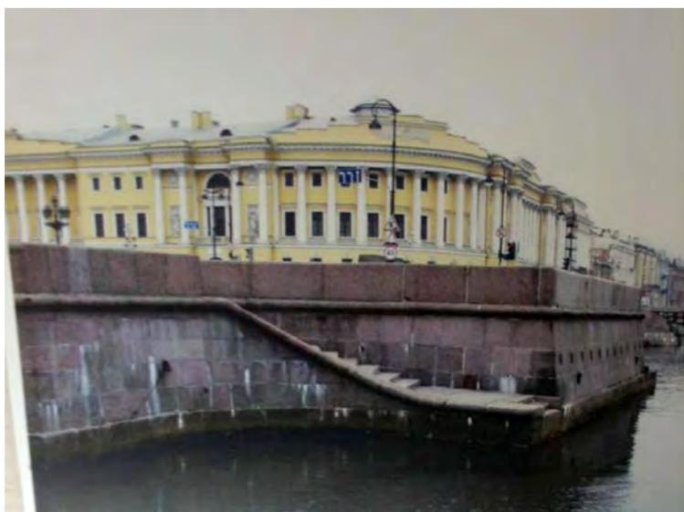
Figuras 27. Embarcadero con escaleras, que descendían hasta el nivel del agua en la orilla del puente de San Isaac junto a la plaza del Senado, diseñado por Agustín de Betancourt en 1820.
