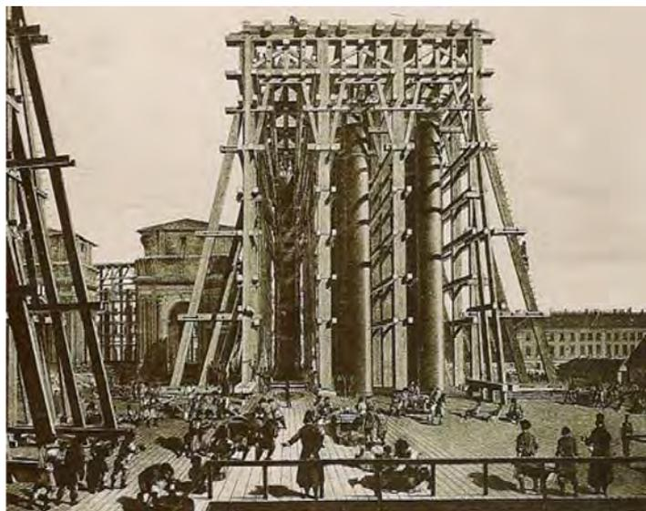
Figura 17. Andamios diseñados por A. Betancourt para instalar las columnas de granito de la catedral de San Isaac.
