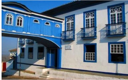
Figura 4 – Passadiço da Glória
