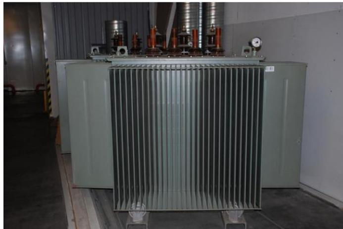
*Figura 42 Imagen del transformador de media tensión.*
