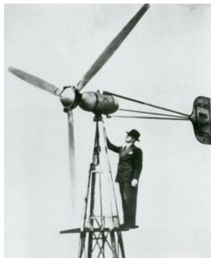
Figura 11 Marcellus Jacobs con su aerogenerador de 2,5 kW en los 1940s. Fuente: <http://www.jacobswind.net/history>
