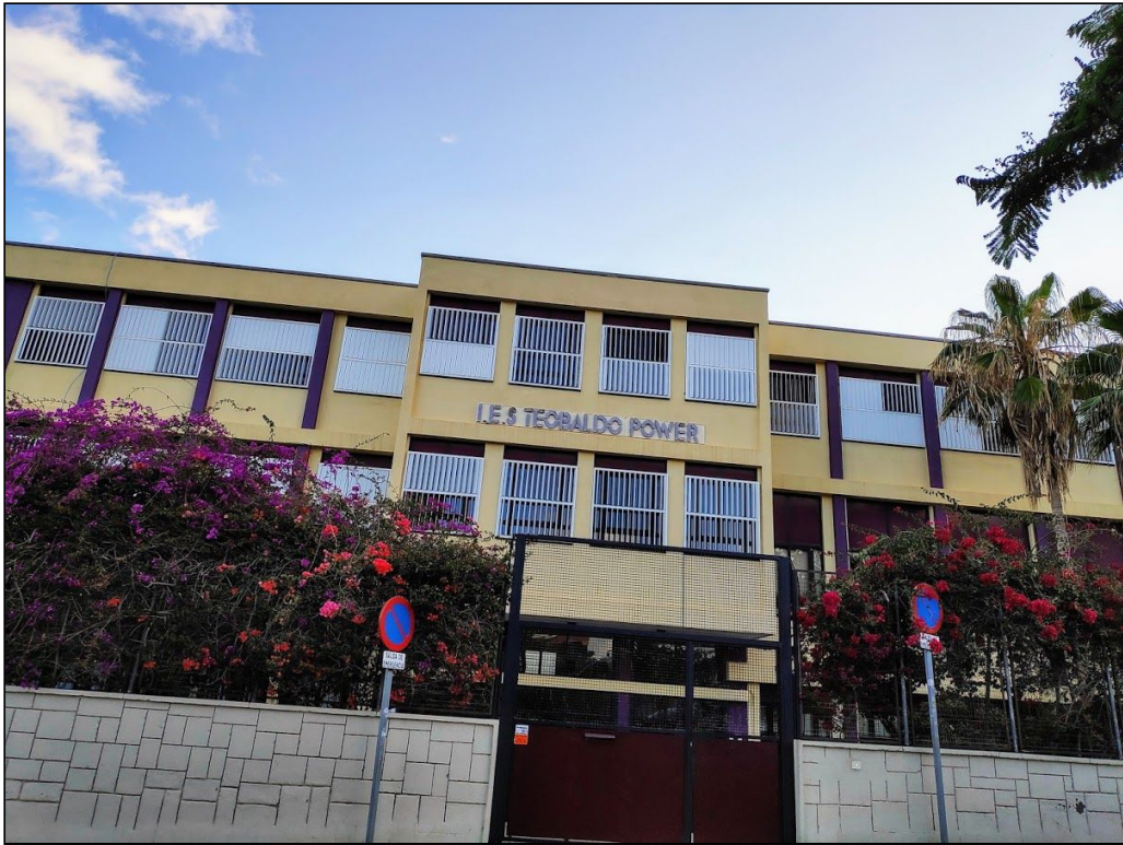
Fig. 3: Fachada principal del IES Teobaldo Power.
