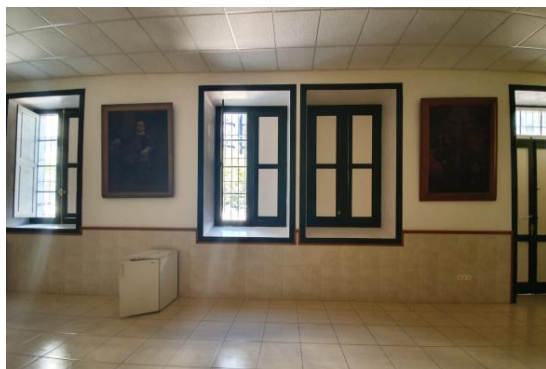
Fig. 127 Fotografía del emplazamiento actual de las obras y su situación respecto a los focos de iluminación natural
