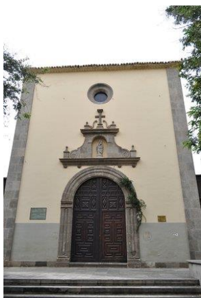
Fig. 1 fachada del exterior de la iglesia
