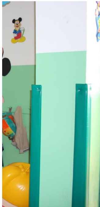
Protección de esquinas.
