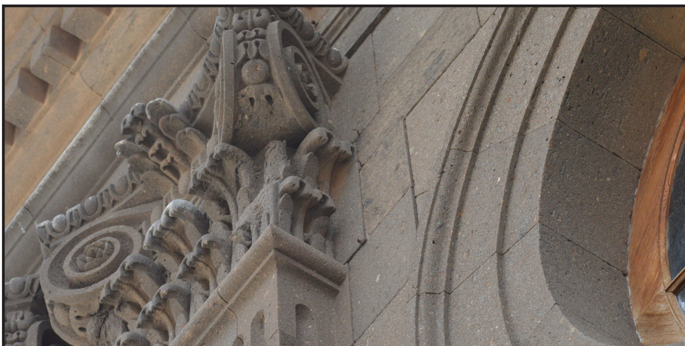
Figura 34. Detalle de la fachada.
