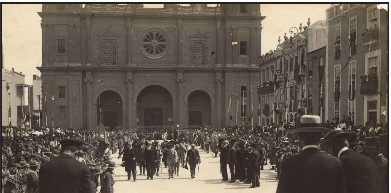
Fig. 12. Concentración en la catedral Santa Ana (1913).
