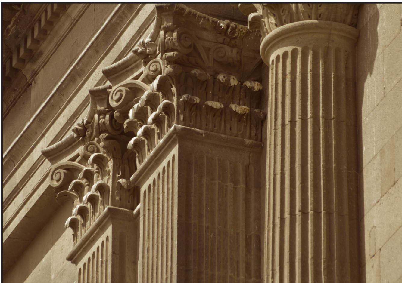
Figura 23. Detalle de la fachada de la catedral de Santa Ana. (2019).
