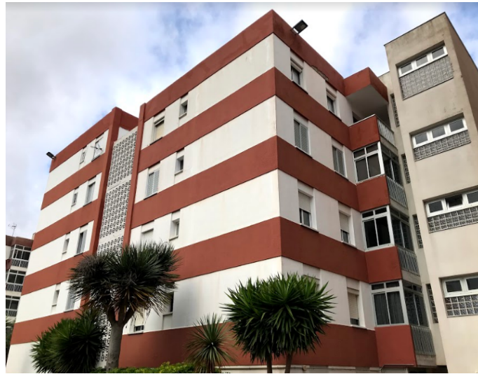
Figura 4. Bloque 10, Fase I, La Verdellada. Fuente: Elaboración propia.
