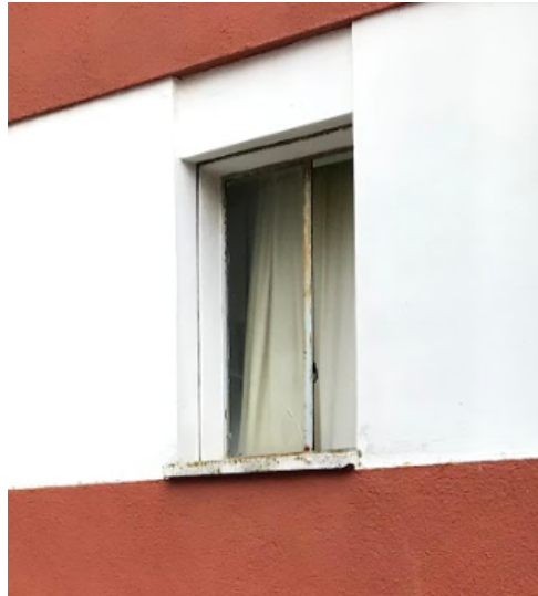
Figura 6. Carpintería exterior. Ventana. Fuente: Elaboración propia.
