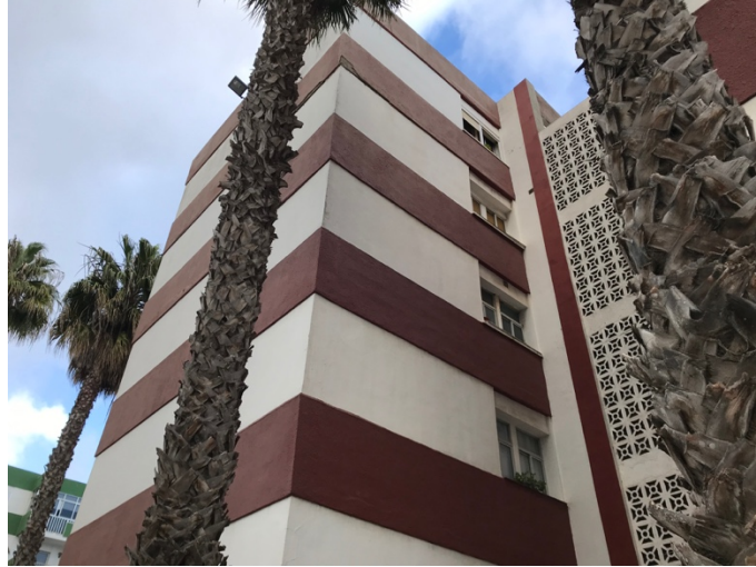
Figura 4. Bloque 11, Fase II, La Verdellada. Fuente: Elaboración propia.
