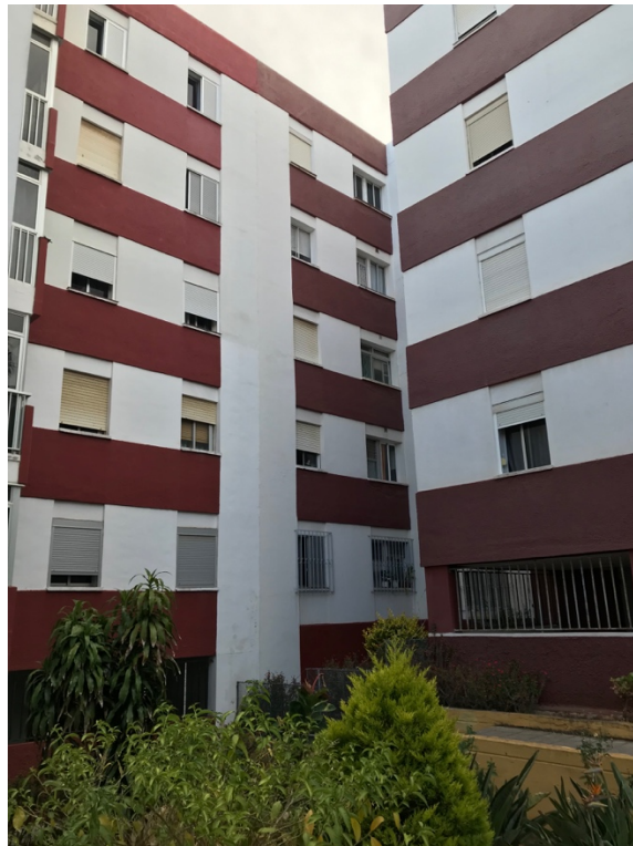
Figura 8. Fachada bloque 11, Fase II, La Verdellada. Fuente: Elaboración propia.
