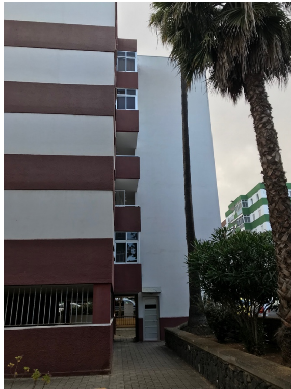
Figura 7. Acceso bloque 11, Fase II, La Verdellada. Fuente: Elaboración propia.
