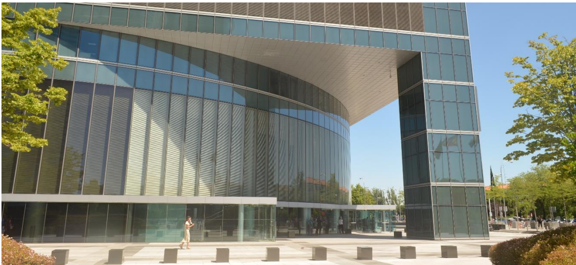
Figura 57. Torre Espacio. Vista del acceso. Elaboración Propia.
