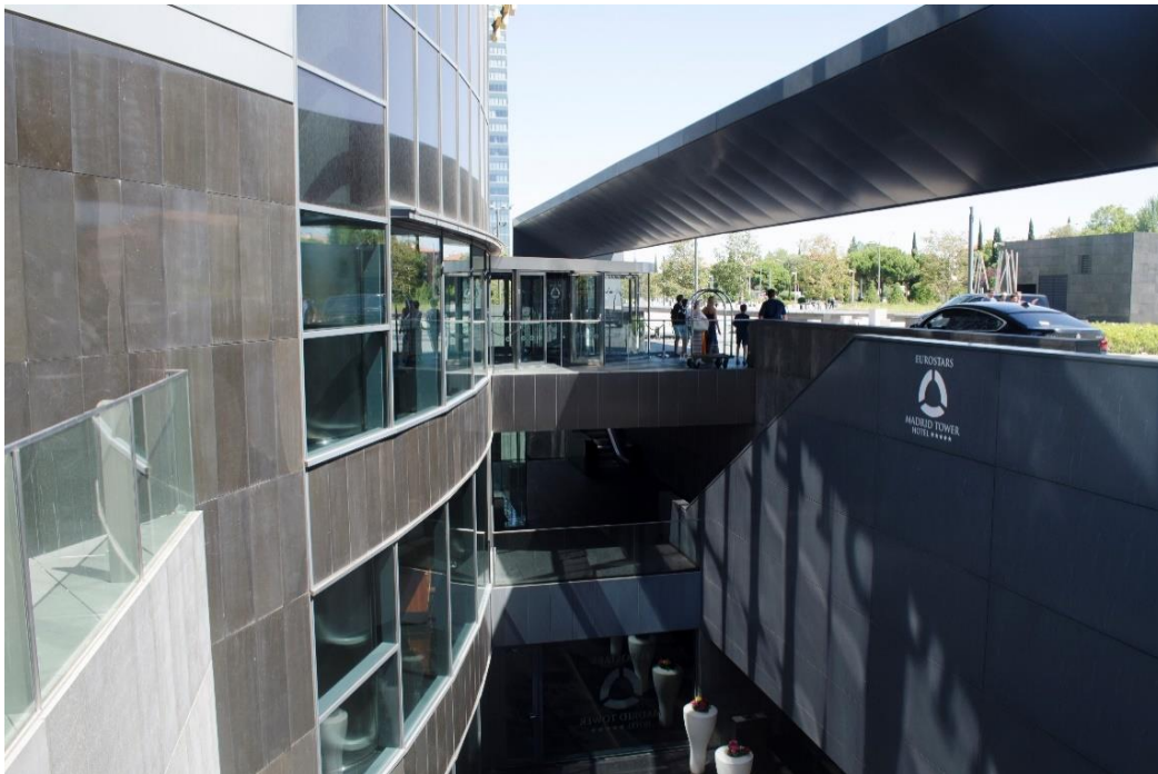
Figura 48. Torre PwC. Vista del acceso y patios. Elaboración Propia.
