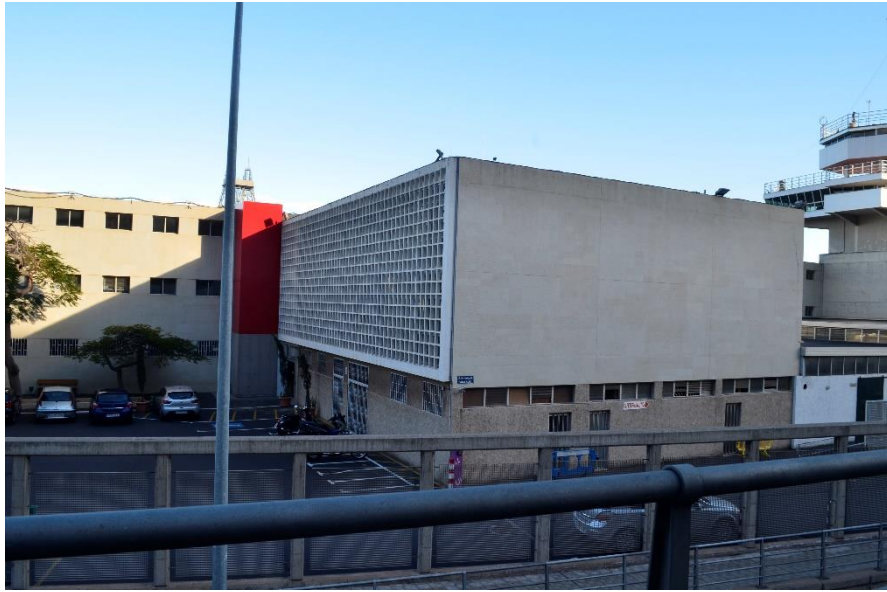
Figura. 45.- Pared de cristalería del salón de actos. Vista desde el exterior
