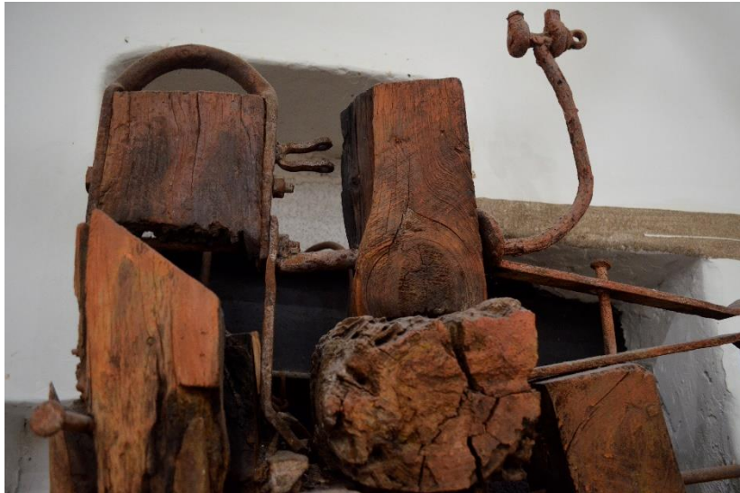
3. B – 2.3 Efecto pictórico de oxidación sobre piezas de hierro y madera
