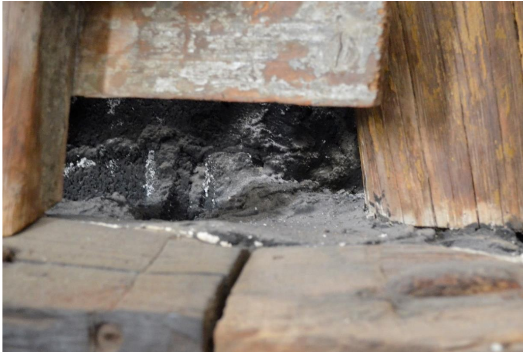
28. D – 8 Sulfatación en el muro
