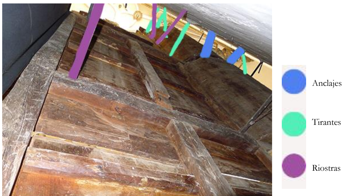
Figura. 8.- Elementos estructurales. Altar principal de San Martín
