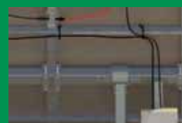
3 Instalación BT DC entre paneles y cajas de conexión
