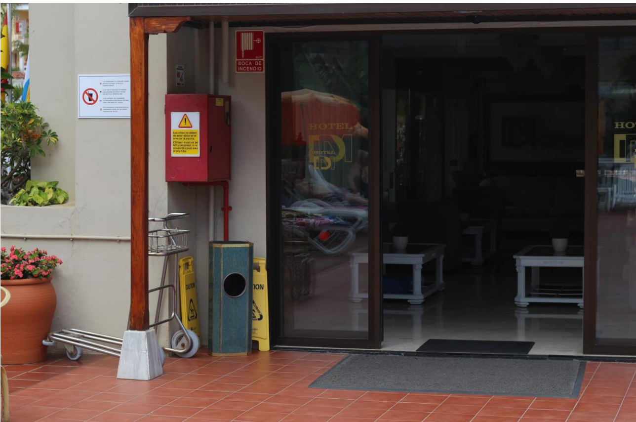
Salida del edificio 1 al solárium
