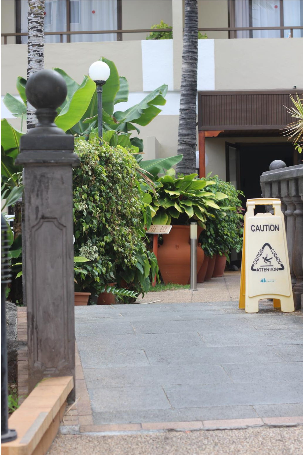
Puente de paso de solárium a Edificio 2 y 3
