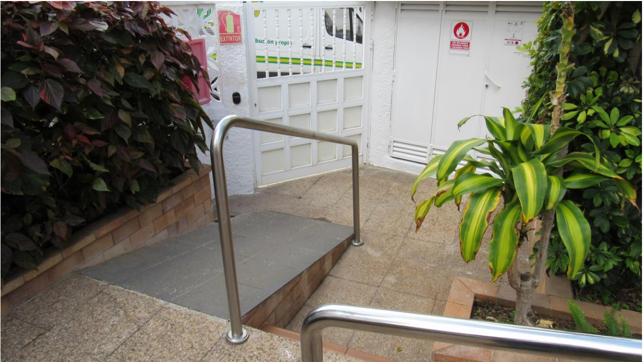
Acceso secundario al hotel, actualmente en desuso, además cuenta con una rampa de pendiente aproximadamente del 30%
