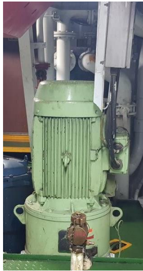
Ilustración 24: Bomba de lubricación del motor principal
