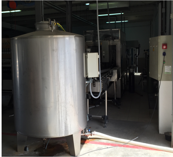
Figura 35. Fuente auxiliar de calentamiento de agua del sistema de ACI.
