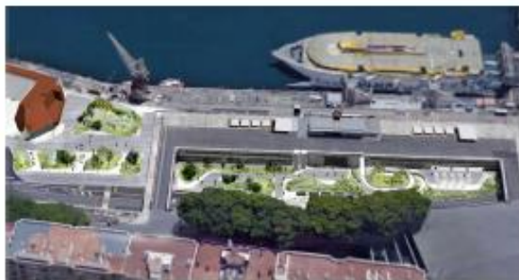
Vistas Exteriores del Edificio.
