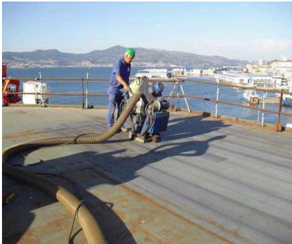
Ilustración 55: Preparación superficie con chorro abrasivo.
