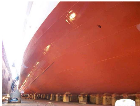
Ilustración 68: Aplicación última capa de HEMPASIL 77500
