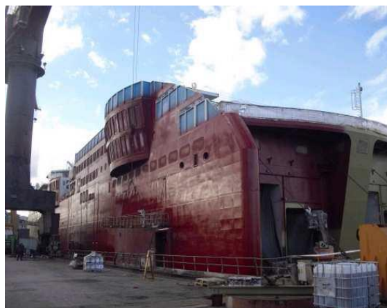
Ilustración 73: Aplicación de HEMPADUR QUATTRO 17634
