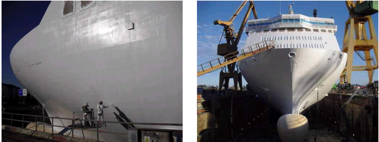
Ilustración 76: Segunda Capa HEMPATEX ENAMEL 56360
