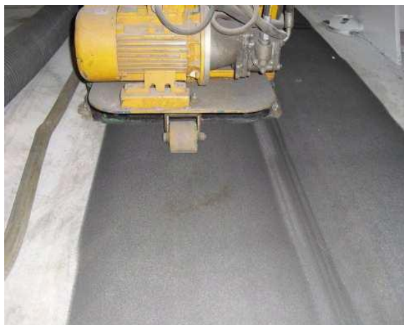
Ilustración 48: Preparado superficie a chorro y capa final piso Bodega HEMPADUR MASTIC (nº 45880 – 40640)
