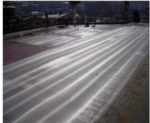
Ilustración 55: Preparación superficie con chorro abrasivo.
