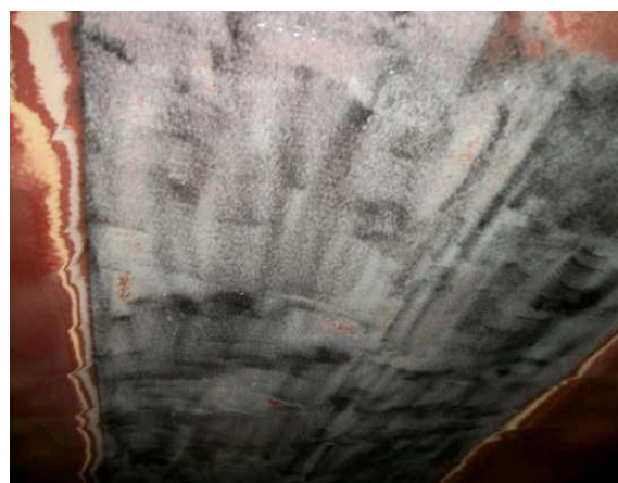
Ilustración 68: Aplicación última capa de HEMPASIL 77500
