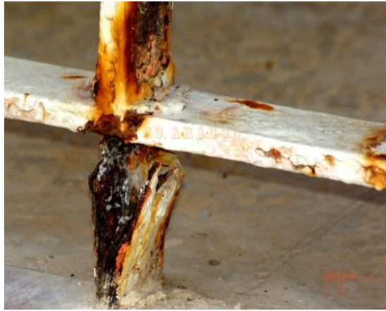
Ilustración N°7: Corrosión Selectiva
