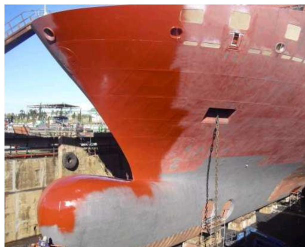
Ilustración 63: Primera capa de HEMPADUR 15570
