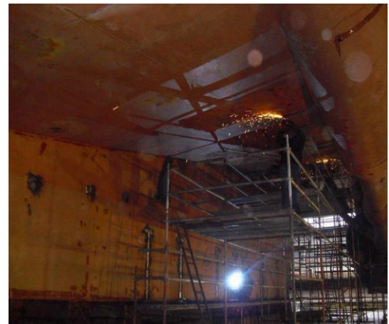
Ilustración 61: Preparación superficie Fondo Plano fregado y lijado
