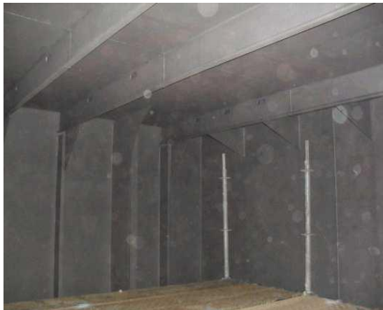
Ilustración 53: Preparación superficie y aspecto final tanques de agua dulce HEMPADUR MULTI-STRENGTH (nº 35530 – 10500)
