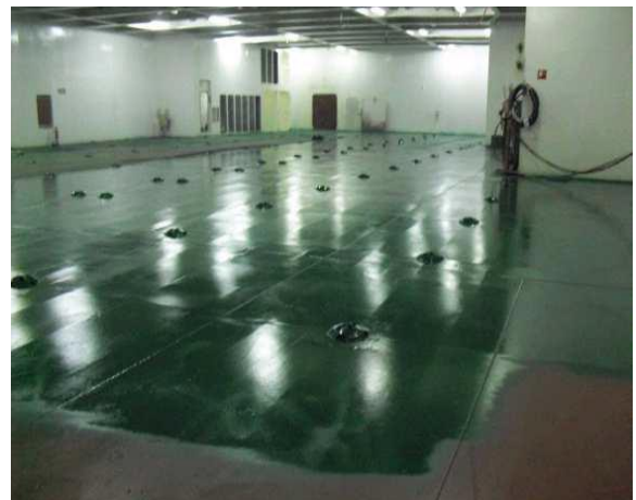
Ilustración 48: Preparado superficie a chorro y capa final piso Bodega HEMPADUR MASTIC (nº 45880 – 40640)
