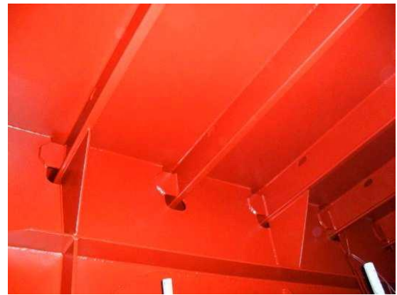
Ilustración 49.50: Preparación superficie y pintado HEMPADUR QUATTRO (nº 17634 – 50630) espacios vacíos.
