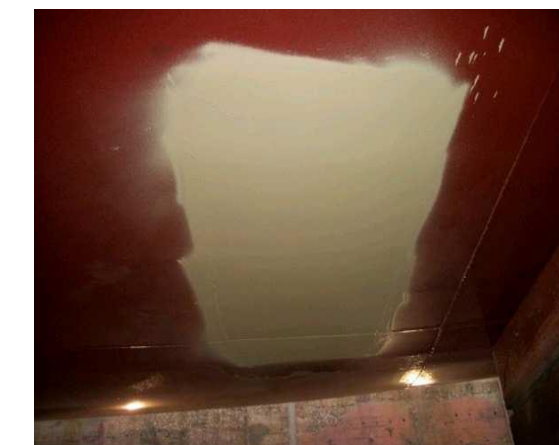
Ilustración 68: Aplicación última capa de HEMPASIL 77500
