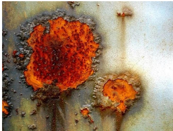
Ilustración N° 12: Corrosión por Mecanismos Biológicos
