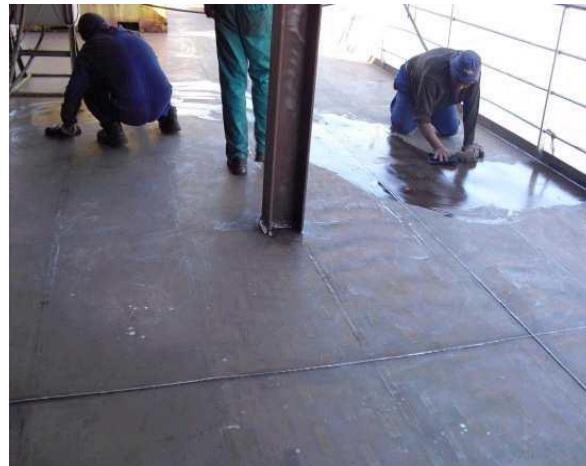
Ilustración 56: Limpieza Superficie con Disolvente.
