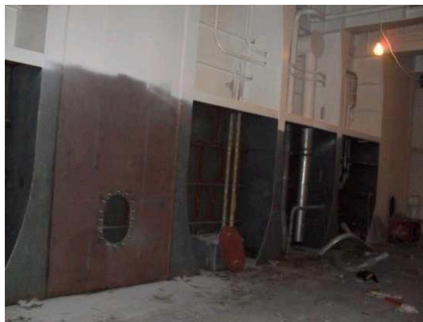
Ilustración 47: Aplicación HEMPADUR MASTIC (nº45880 – 10000) Techo Bodega
