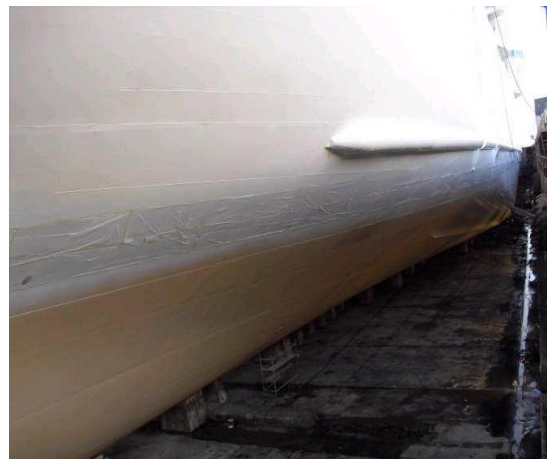
Ilustración 65: Lijado del Bulbo tras pintar costados y protección del costado.
