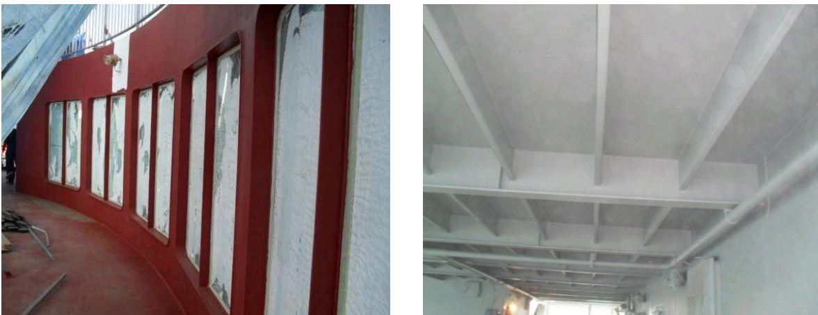
Ilustración 59: Sección de Infraestructura pintada por capa HEMPADUR CUATTRO (n° 17634) y capa de HEMPADUR (n° 45182 – 10500)
