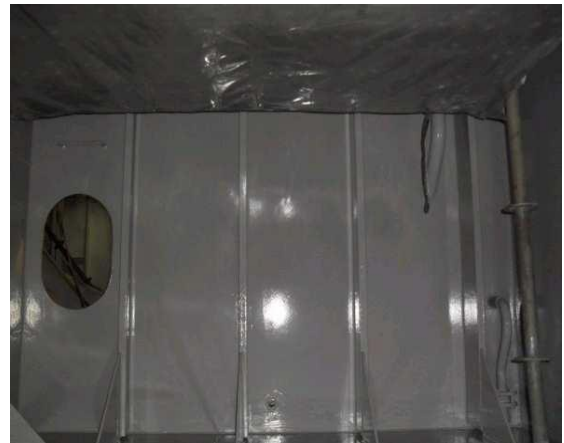
Ilustración 53: Preparación superficie y aspecto final tanques de agua dulce HEMPADUR MULTI-STRENGTH (nº 35530 – 10500)
