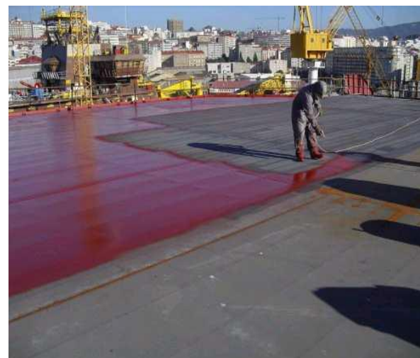
Ilustración 57: Aplicación a rodillo (izq) y pistola (dcha) capa HEMPADUR QUATTRO (n° 17634 – 50630)
