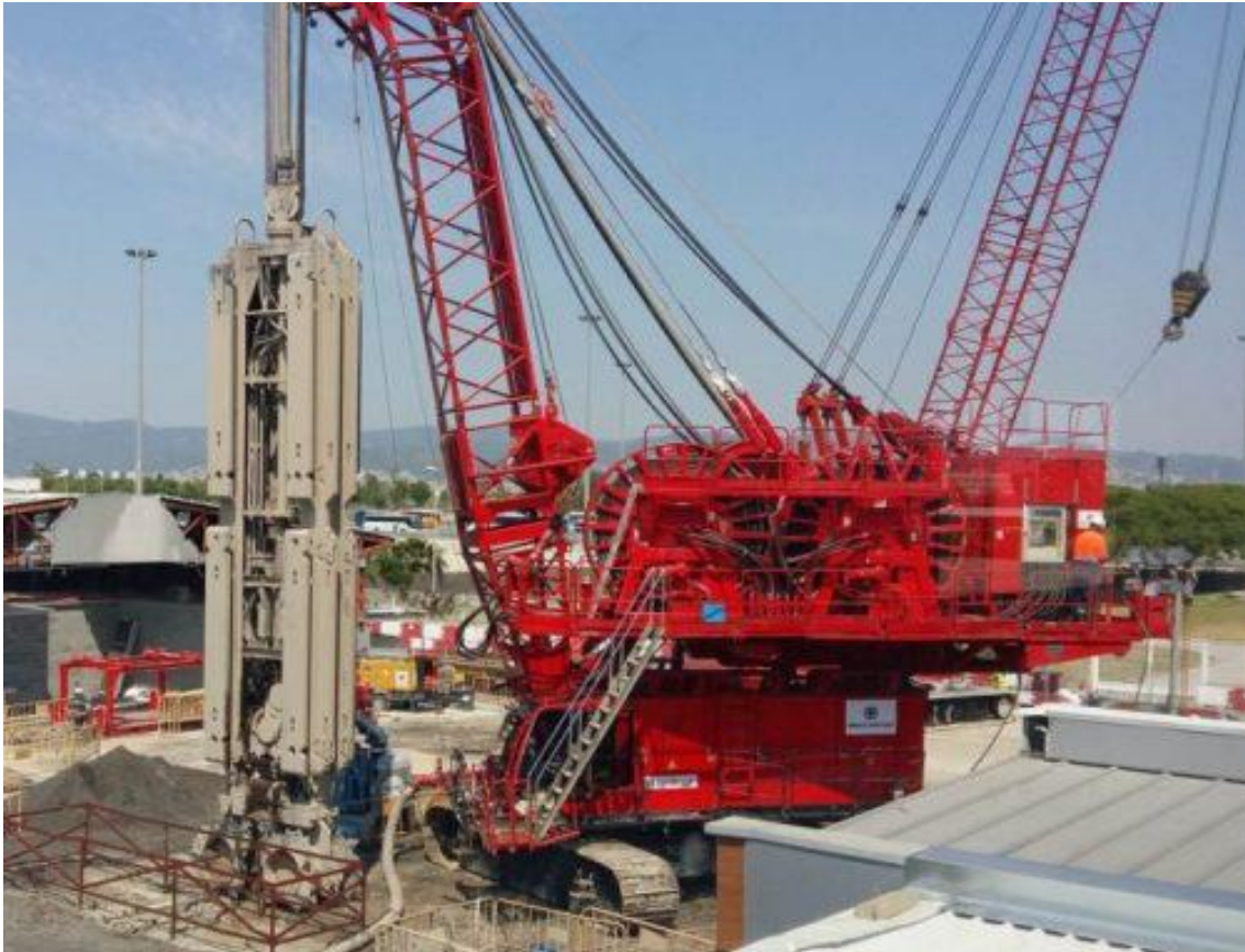
13-Grua de cimentación, radiokrosa.es
