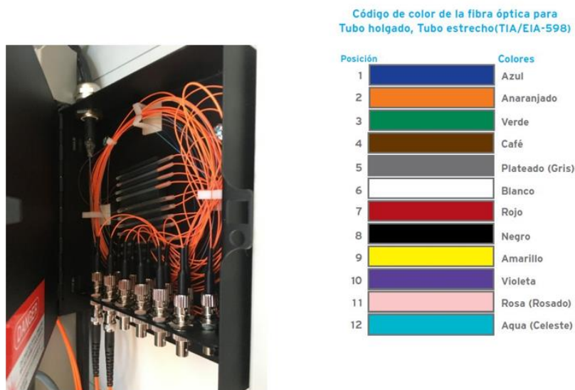
Figura 26 Cajetín de fusión de fibras (izquierda). Código de color de fibra óptica (derecha), extraído de [32]
