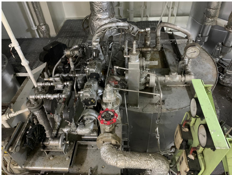
Ilustración 16: "Vista superior caldera buque Tinerfe"
