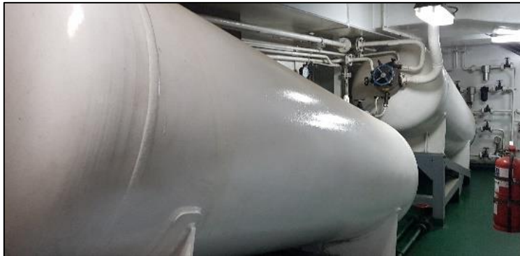
Ilustración 15: Botellas de aire comprimido.
