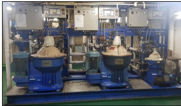
Ilustración 18: Módulo de depuradoras.
