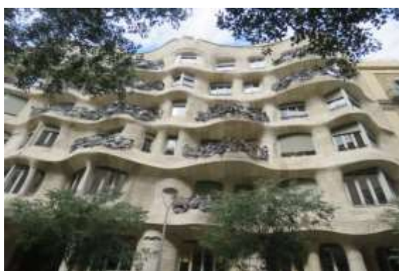
Fig. 52 Detalle de la fachada
