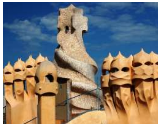
Fig. 58 Detalle de las chimeneas de la azotea
