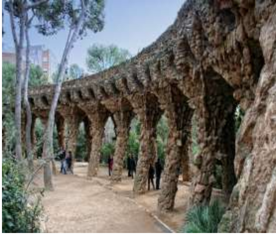
Fig. 37 Imagen de los viaductos de piedra
