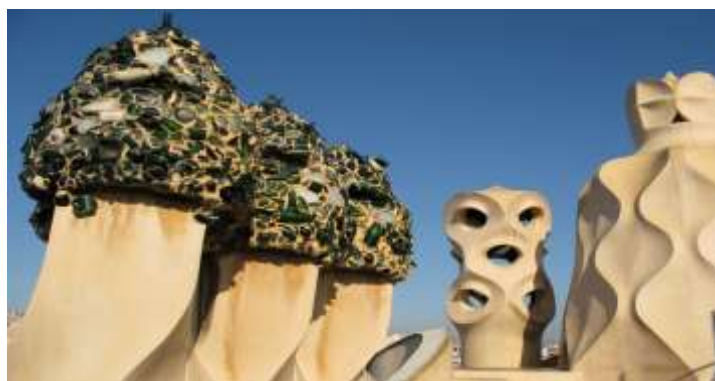
Fig. 59 Detalle de las chimeneas adyacentes a las escaleras
