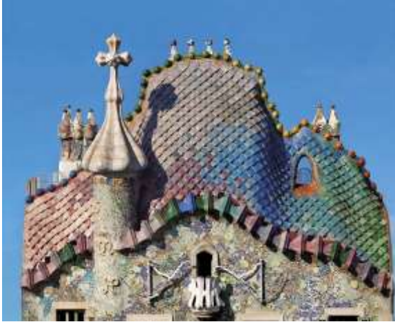
Fig. 45 Detalle de la parte superior de la fachada
