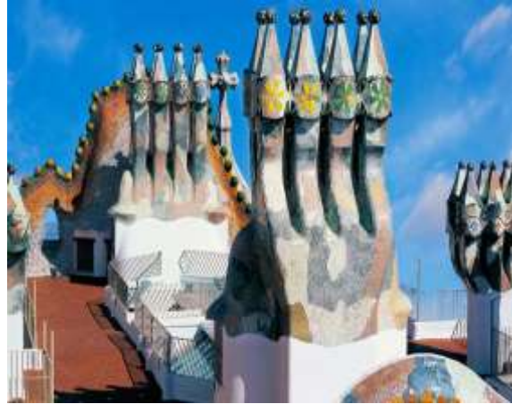
Fig. 50 Detalle de la azotea
