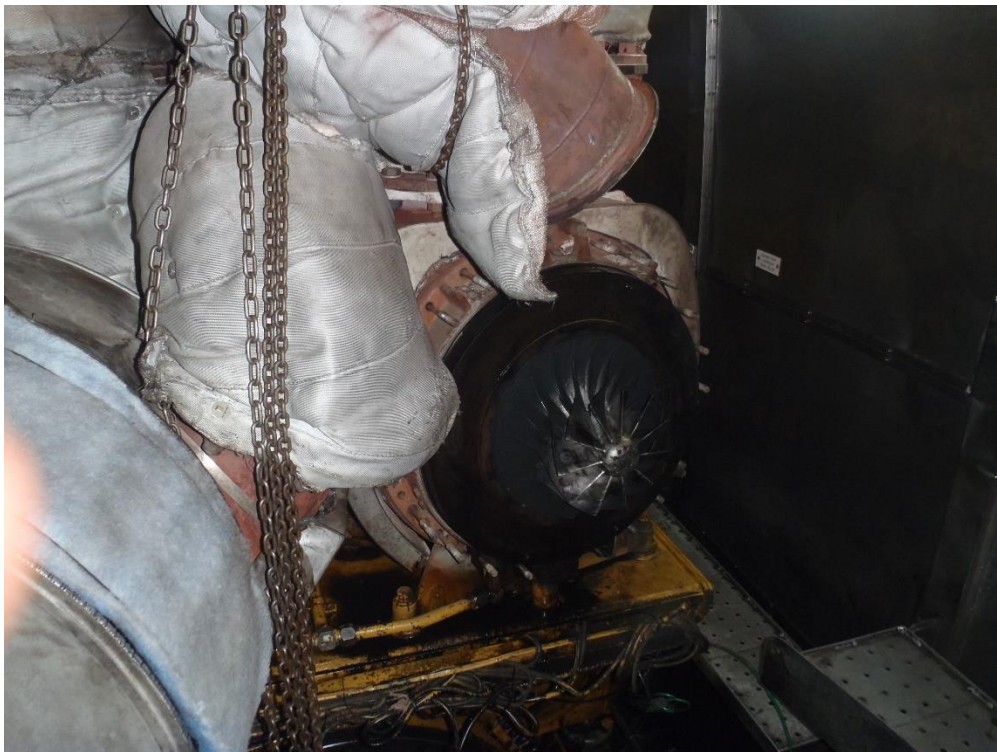
Ilustración 40 Ilustración de maniobra desmontaje turbo ABB modelo TPL 65 MMPP SOME. Fuente: Trabajo de campo.
