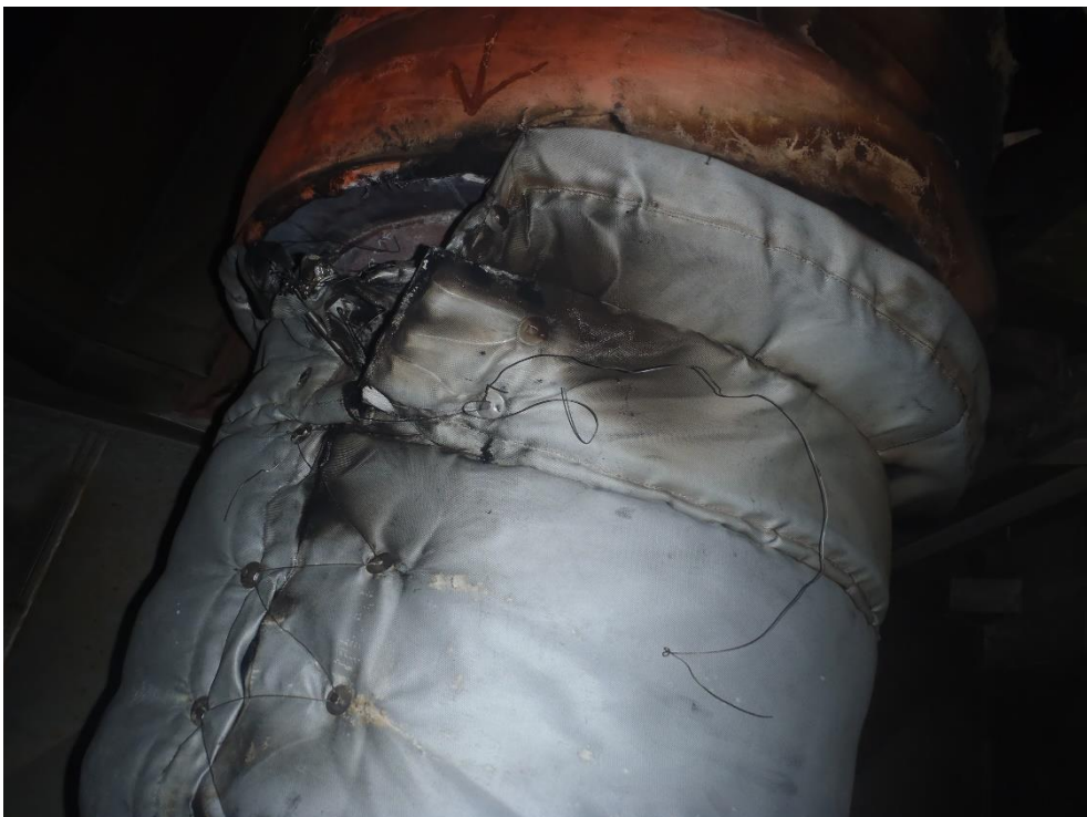
Ilustración 61 Ilustración de pérdidas de escape por silencioso de MMPP. Fuente: Trabajo de campo.
