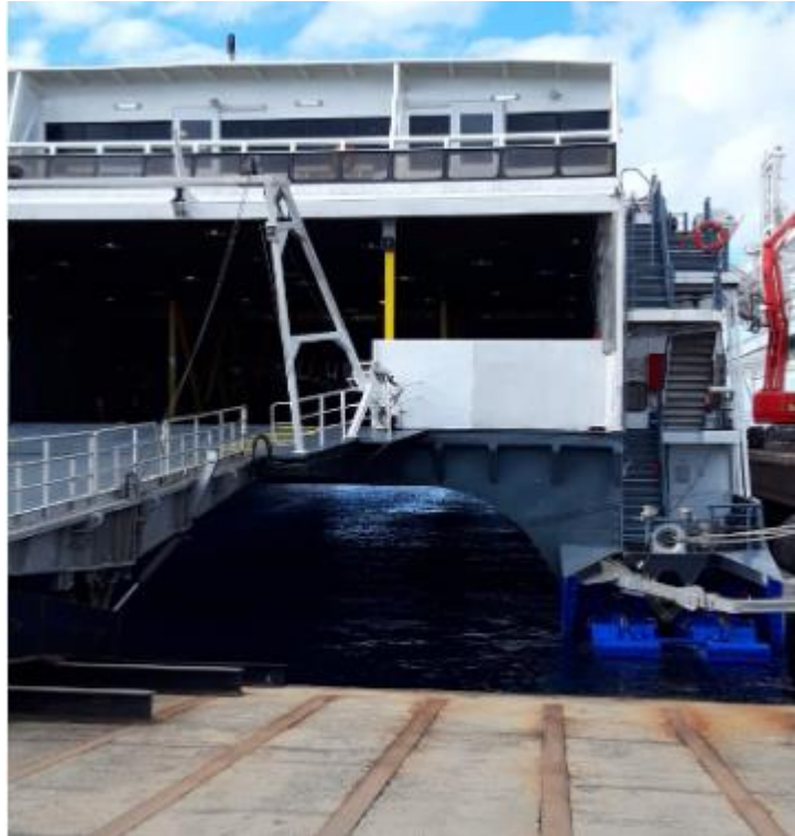
Ilustración 8. Rampa de acceso a la bodega de carga. Fuente: trabajo de campo.
