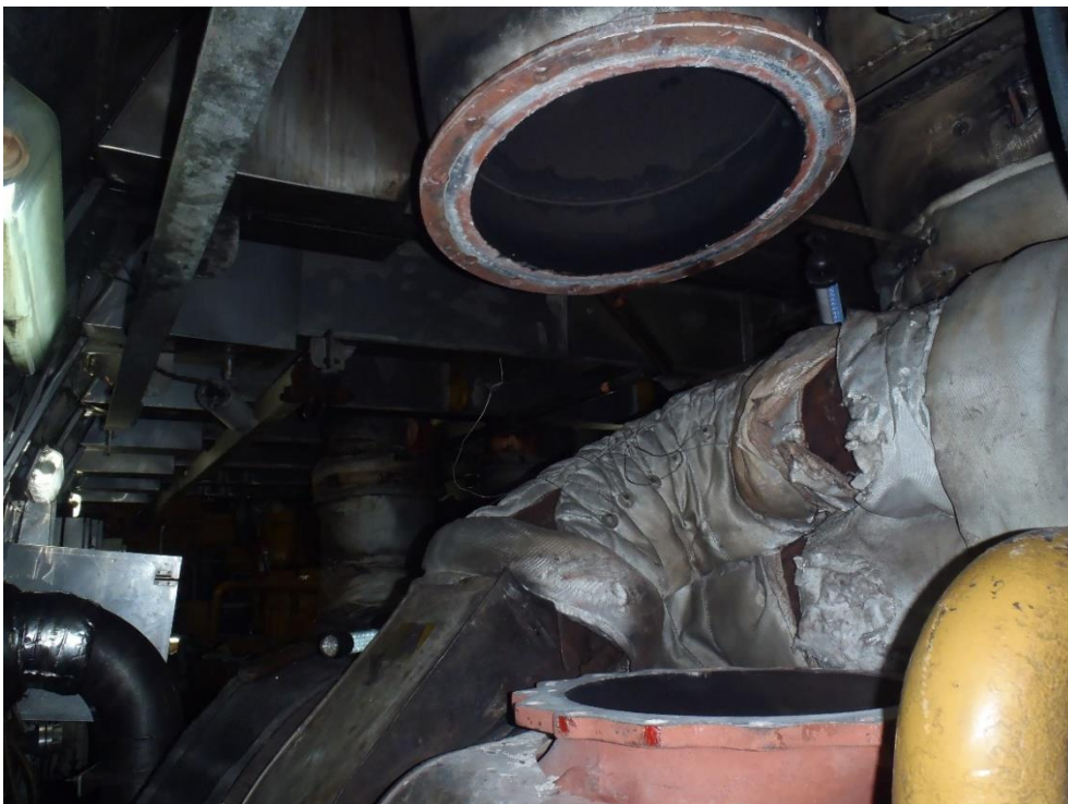
Ilustración 57 Ilustración de forros de escape y salida de escape. Fuente: Trabajo de campo.
