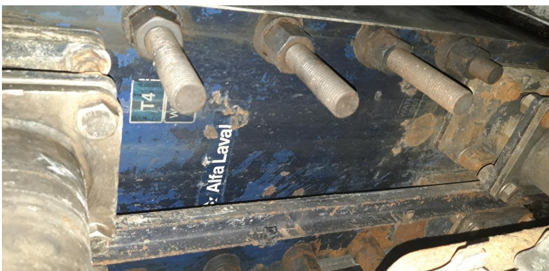
Ilustración 49 Ilustración de Intercambiador de placas. Fuente: Trabajo de campo.
