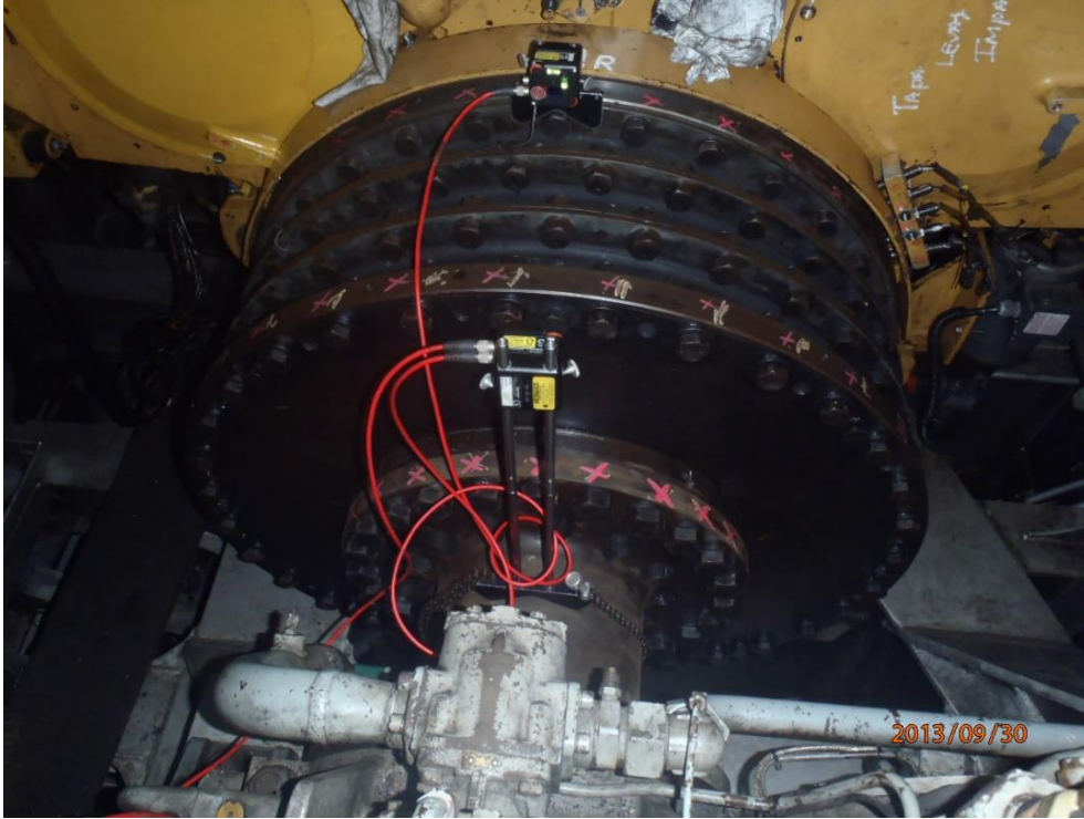
Ilustración 56 Ilustración de alineación del eje con el acoplamiento "Vulkan". Fuente: Trabajo de campo.
