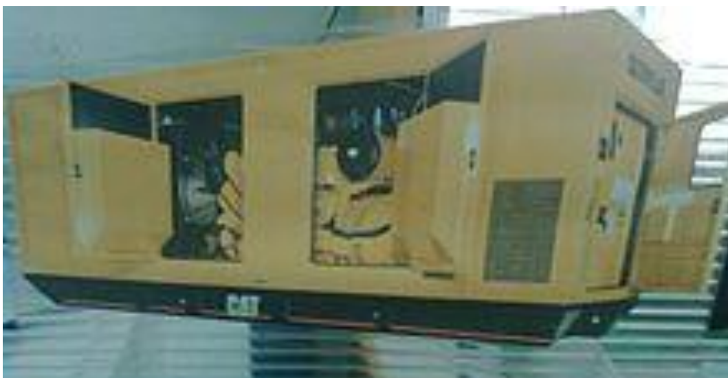
Ilustración 1. Generador diésel Caterpillar. Fuente: caterpillarpeten.blogspot
