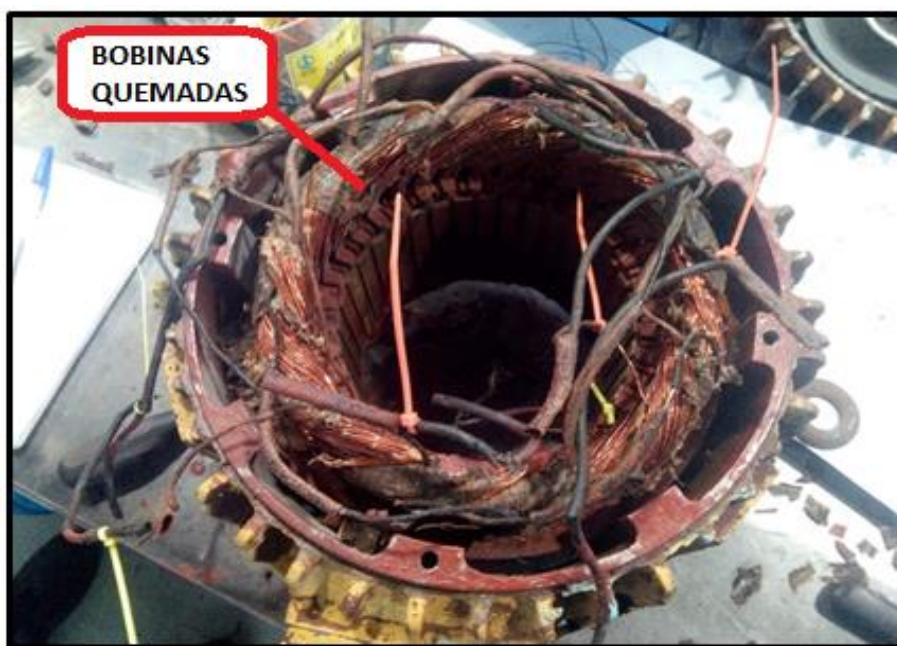
Ilustración 36. Devanado con sus conexiones. Fuente: Elaboración propia.
