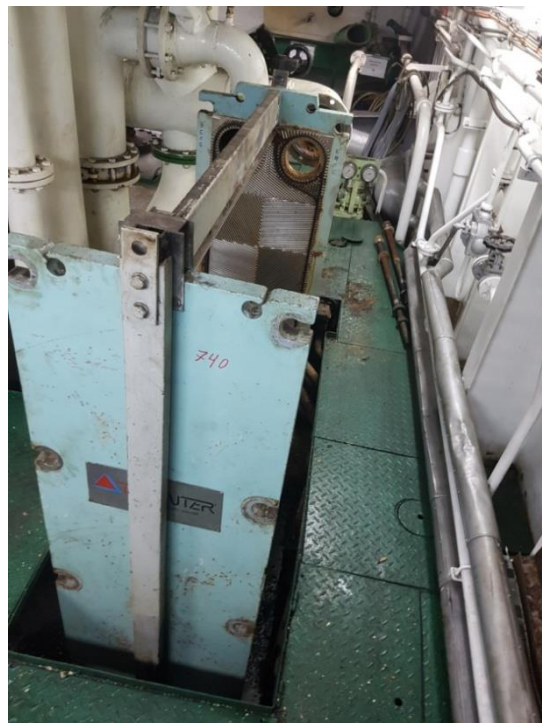
Ilustración 20. Enfriador principal A.S. Fuente. Trabajo de campo
