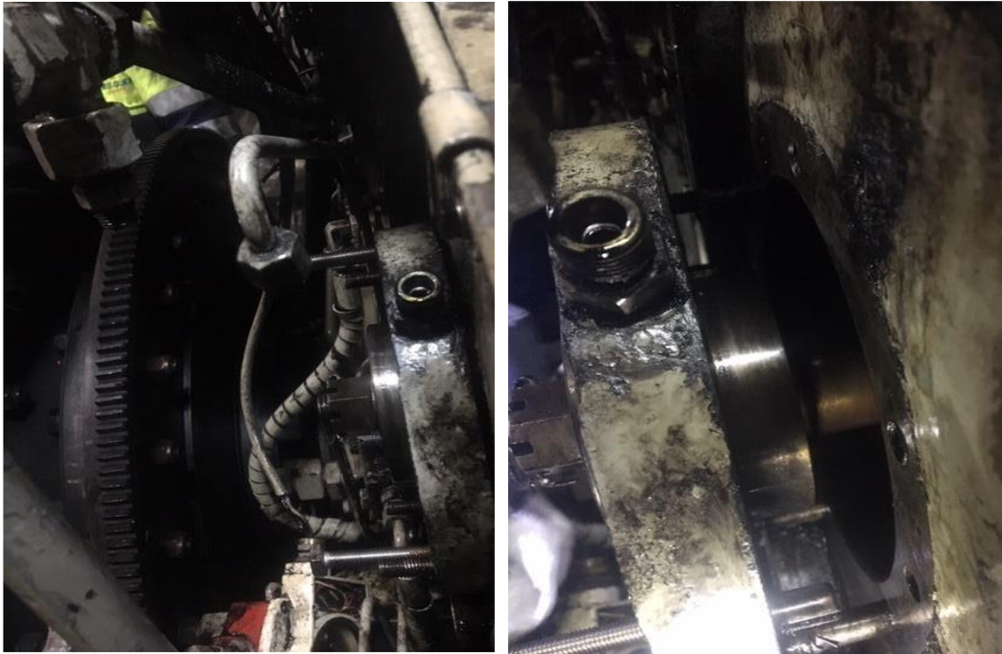
Ilustración 43. Desplazamiento Eje de camones. Fuente. Trabajo de campo.
