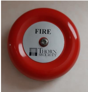
Imagen 32: Timbre de alarma - Fuente: Buque Esperanza del Mar
