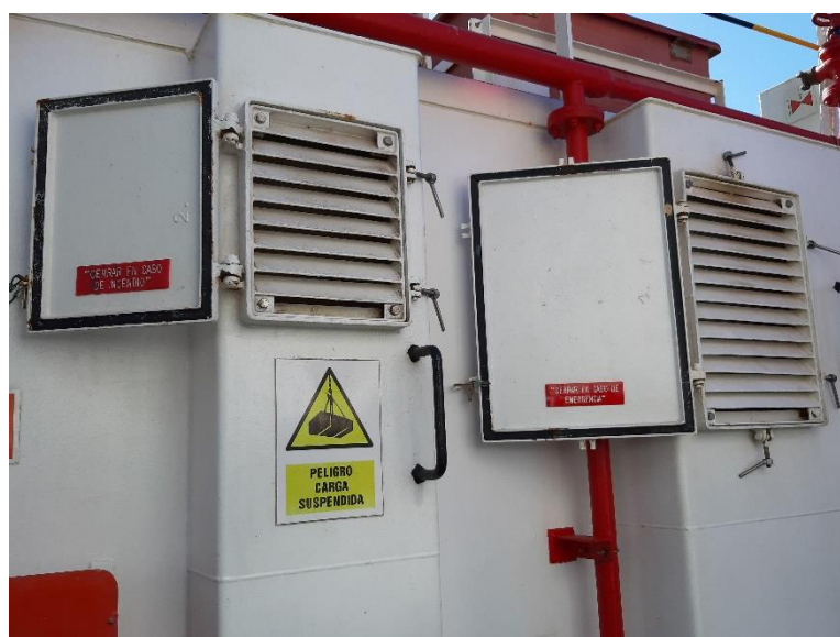
Imagen 62: Ventilaciones y tapas de cierre - Fuente: Buque Esperanza del Mar
