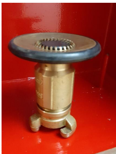
Imagen 55: Lanza contra incendios a bordo - Fuente: Buque Esperanza del Mar
